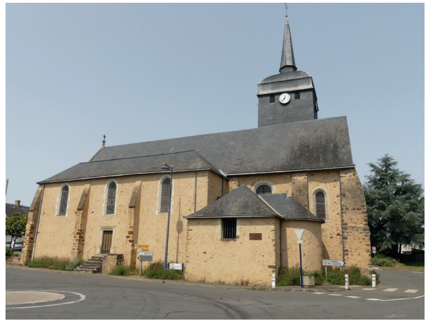
▲ La façade sud de l'église, depuis l'est
