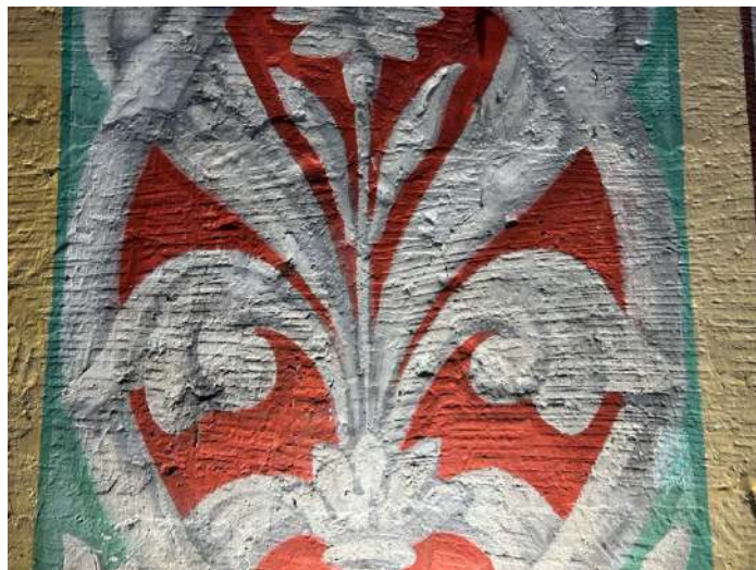
Intrados de l'arc peint directement sur les pierres finement jointoyées et apprêtées.
