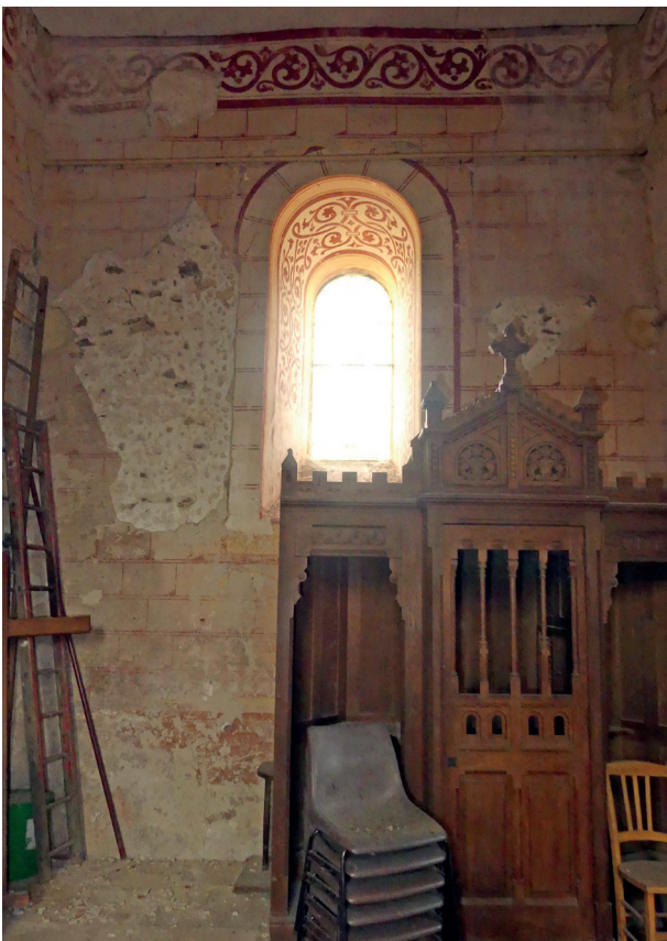
▲ Mur nord de la chapelle nord sous clocher
