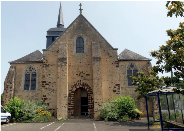
▲ Façade occidentale de l'église de Moncé-en-Belin avec les baies gothiques remontées
