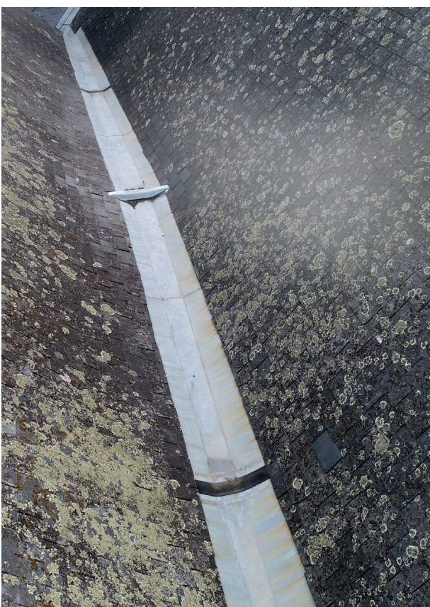
▲ Chéneaux en assez bon état
