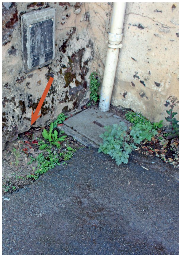
▲ Regard en assez bon état
