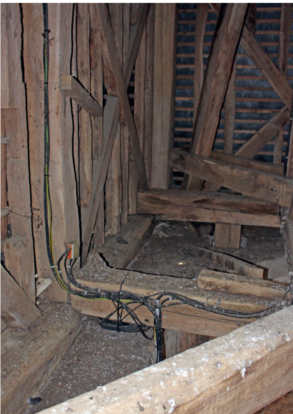
▲ Clocher. Assez bon état général du beffroi
