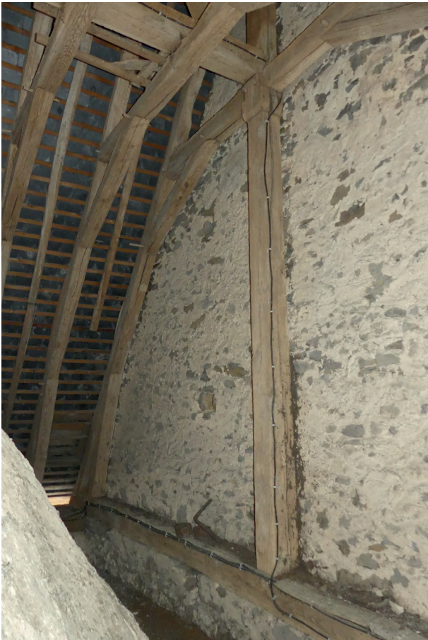
▲ Ferme de la charpente du chœur de l'église de Moncé-en-Belin
