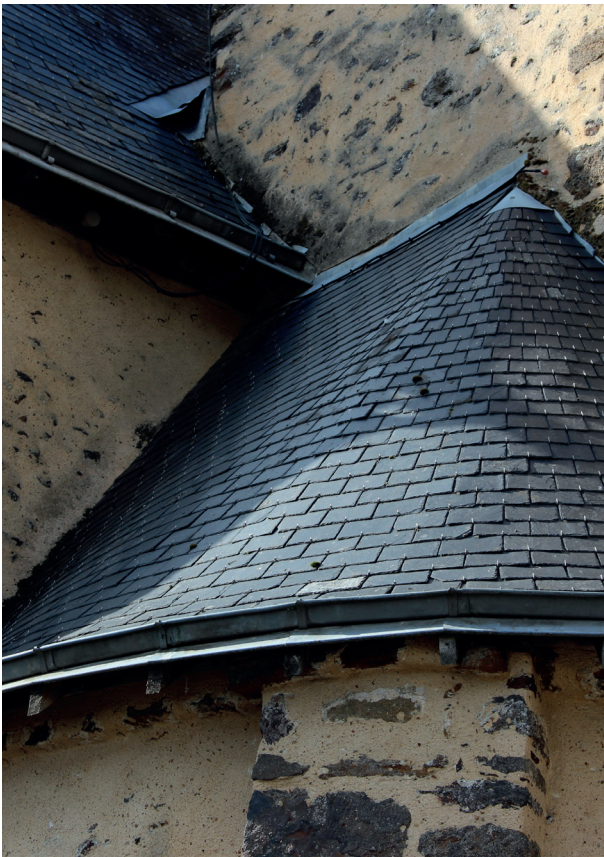
▲ Absidiole nord. Bon état de la couverture
