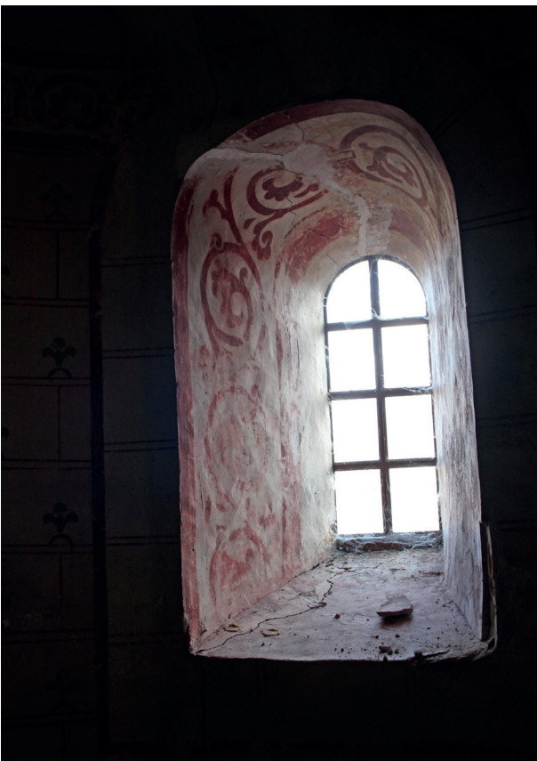
▲ Rez-de-chaussée du clocher. Repeints multiples
