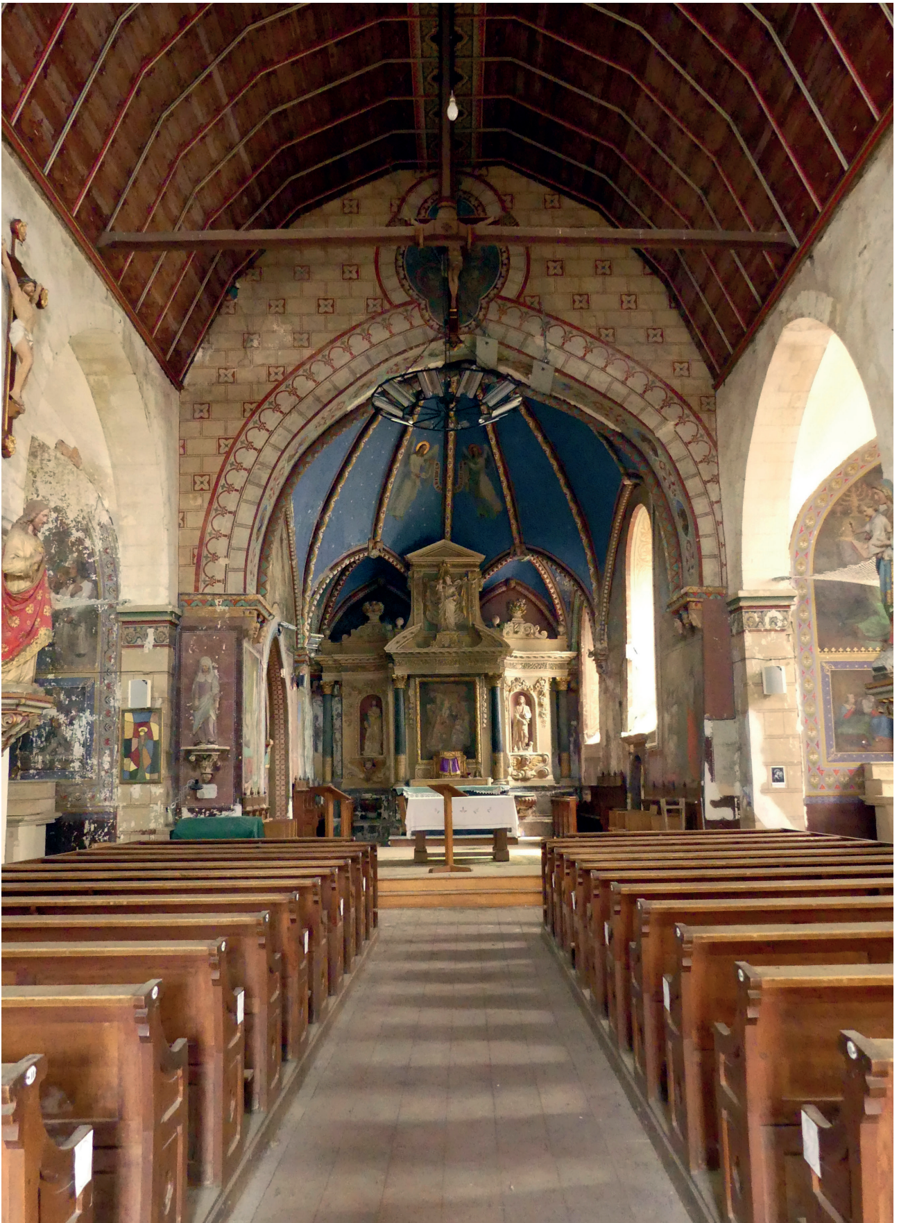
▲ Photographie de la voûte de la nef à la fin XIX e siècle. Une poutre de gloire et un bout du jubé sont visibles ©popculture.gouv.fr
