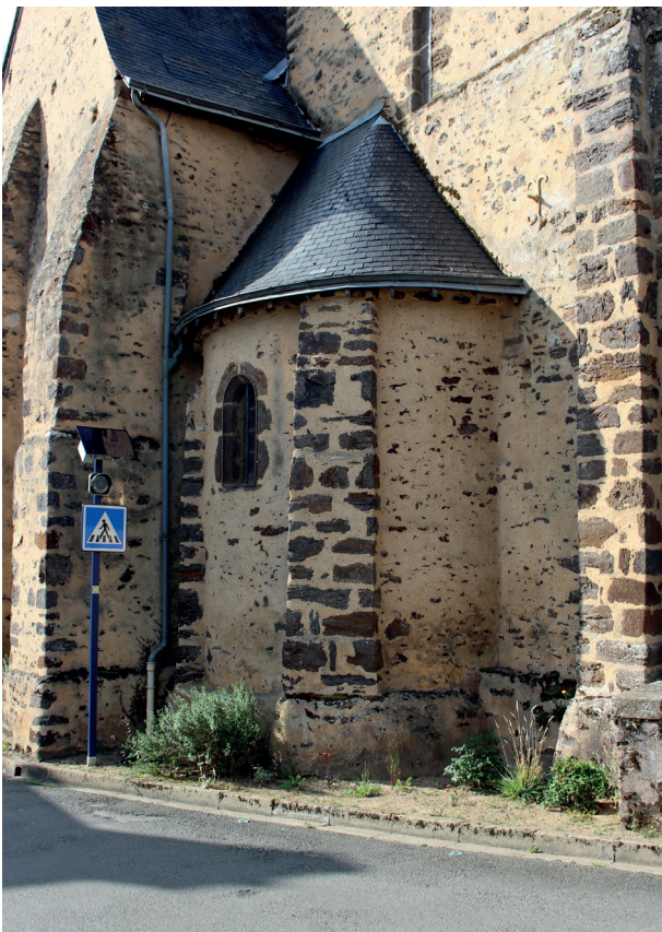
▲ Assez bon état général du chevet
