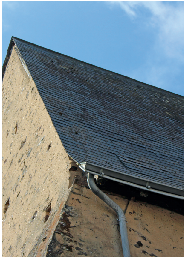
▲ Chevet. Assez bon état de la couverture
