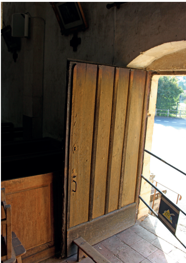
▲ Porte sud. Assez bon état général
