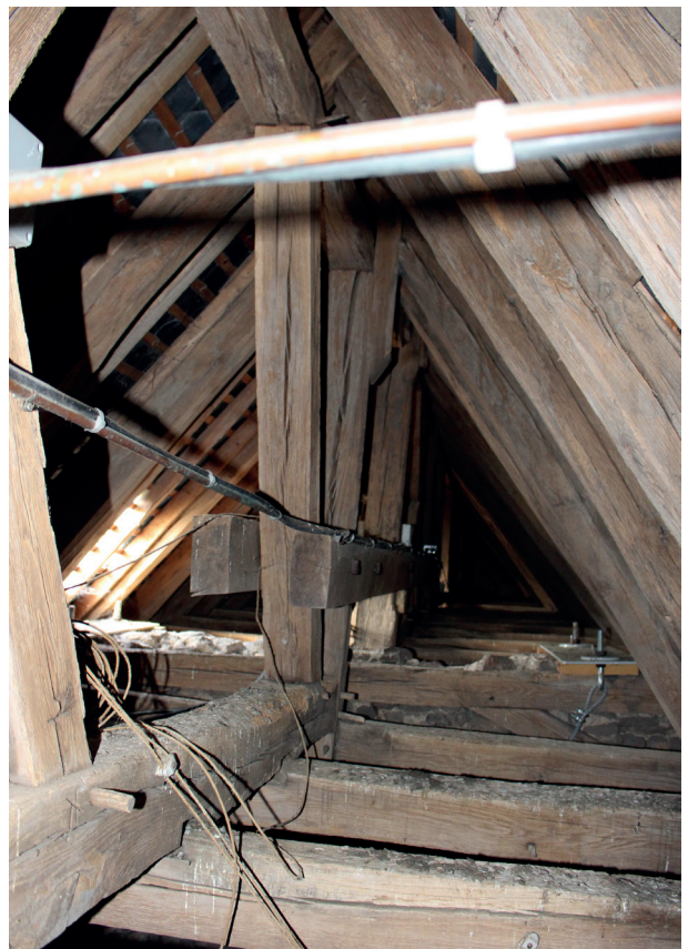
▲ Nef. Assez bon état général de la charpente
