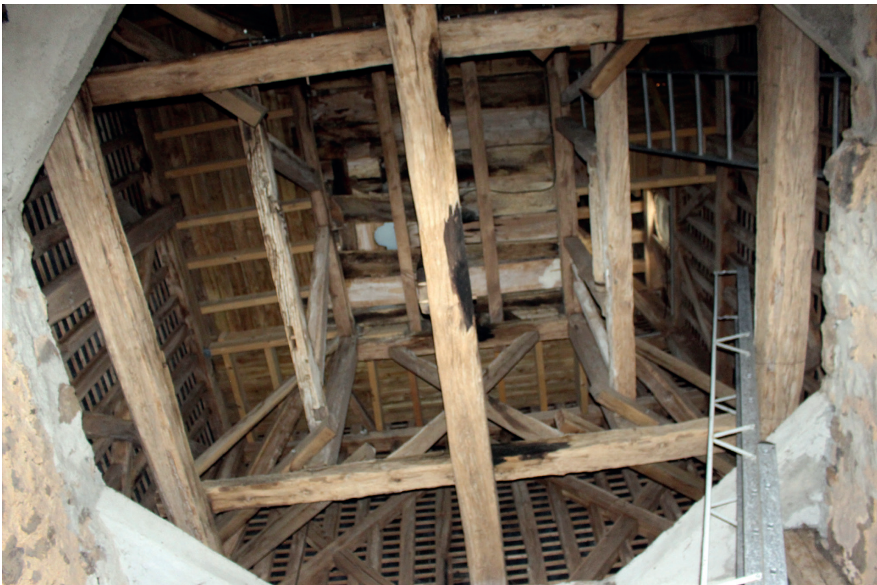
▲ Clocher. Assez bon état général
