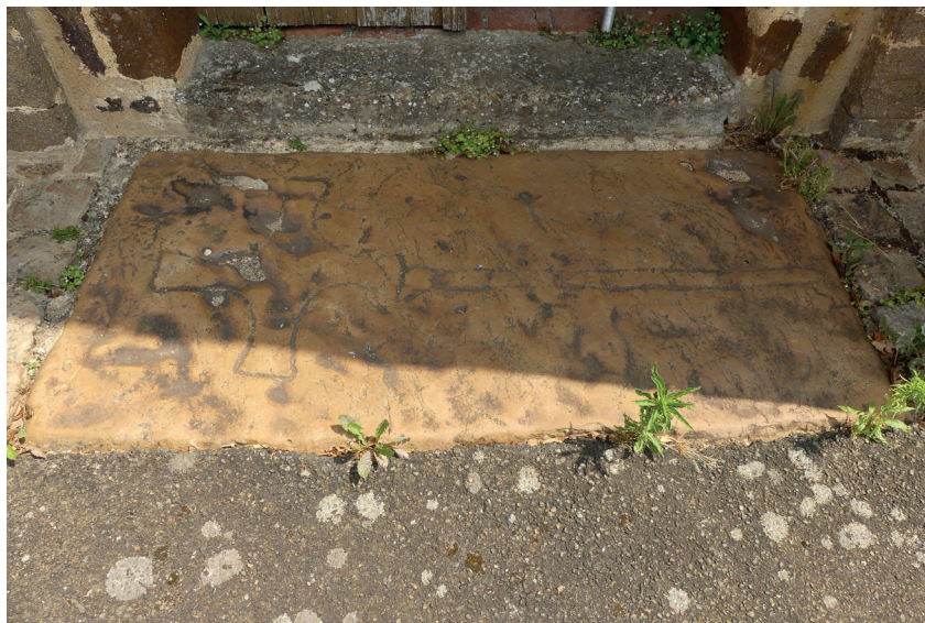
▲ La pierre tombale du XIII e siècle, utilisée comme seuil du portail
