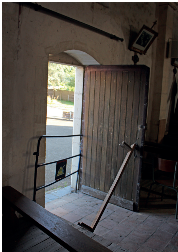
▲ Porte nord. Bon état général
