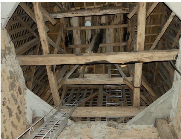
▲ Tour de cloches, charpente du beffroi
