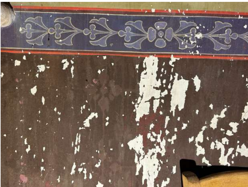
Bas-côté nord : décor sous-jacent visible en lumière rasante
