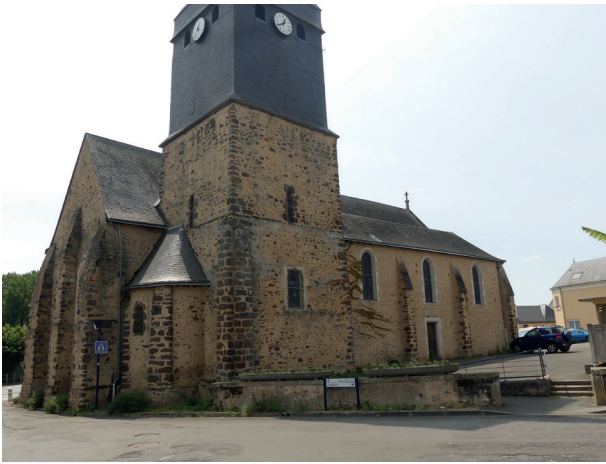
▲ La façade nord de l'église, depuis l'est
