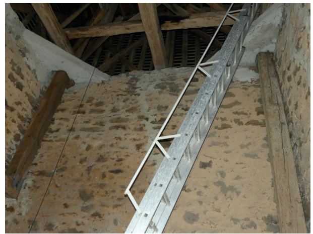
▲ Tour de cloches, premier étage, vers l'ouest
