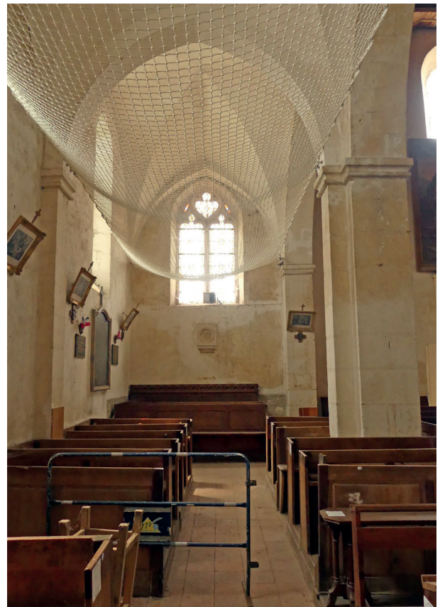
▲ Bas-côté sud vers l'ouest
