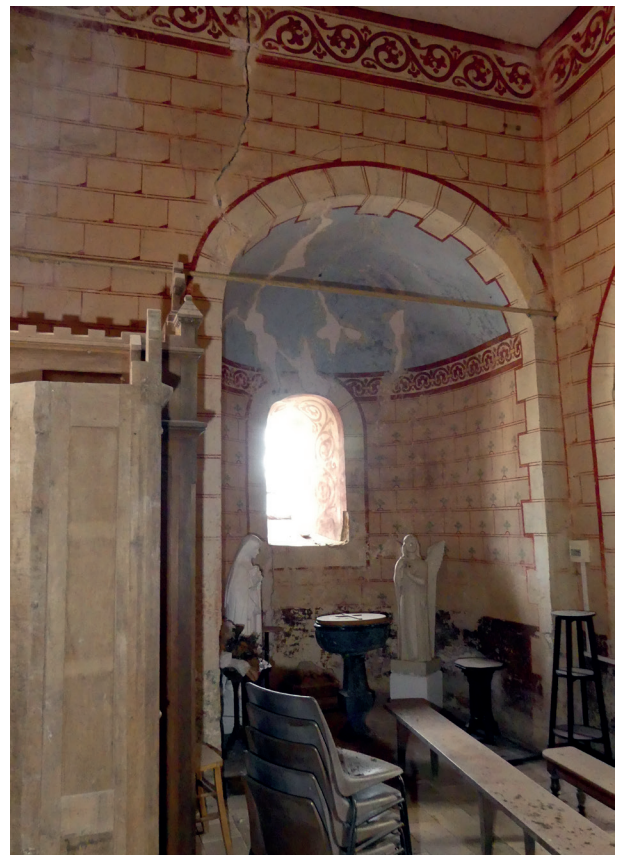
▲ Absidiole de la chapelle nord sous clocher
