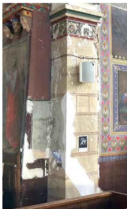
Bouchage au plâtre laissé brut – pilier sud
