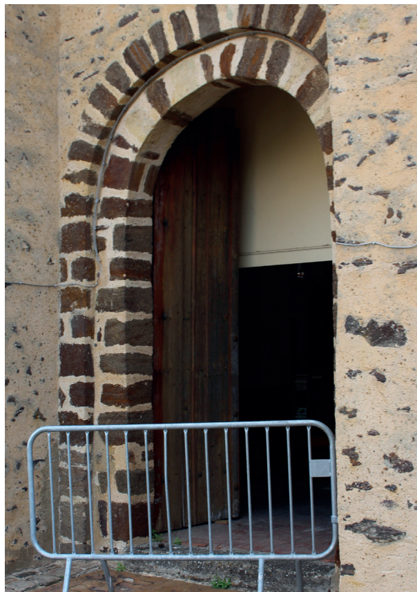
▲ Porte ouest. Bon état général
