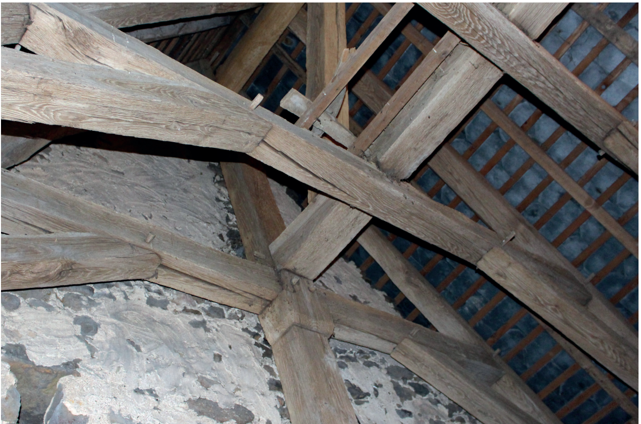
▲ Choeur. Charpente en bon état général
