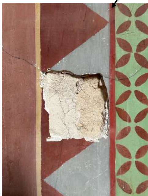
Enduit de dégrossi beige Enduit de finition gris Plâtre
