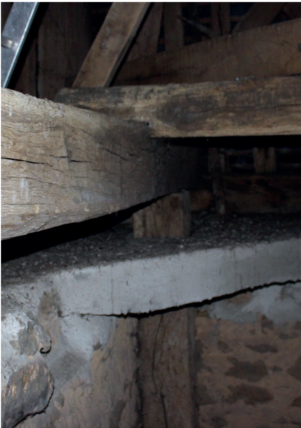
▲ Clocher. Chaînage béton en arase
