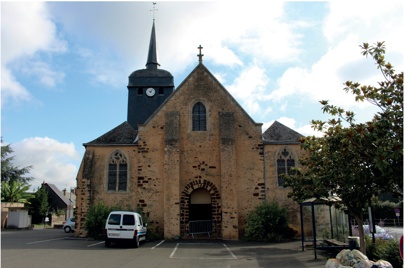
▲ Assez bon état général de la façade occidentale
