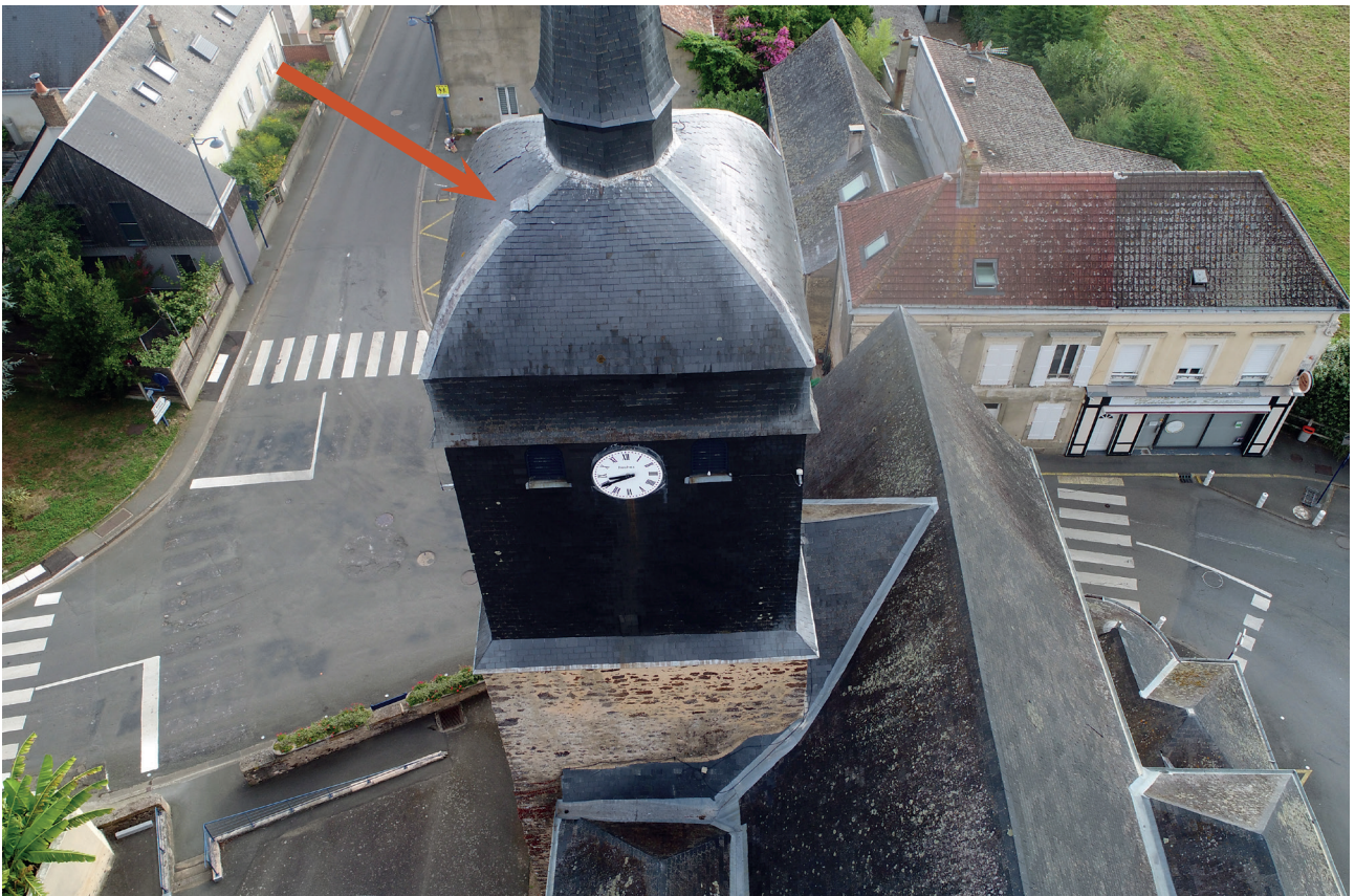
▲ Clocher. Bon état général, malgré quelques désordres
