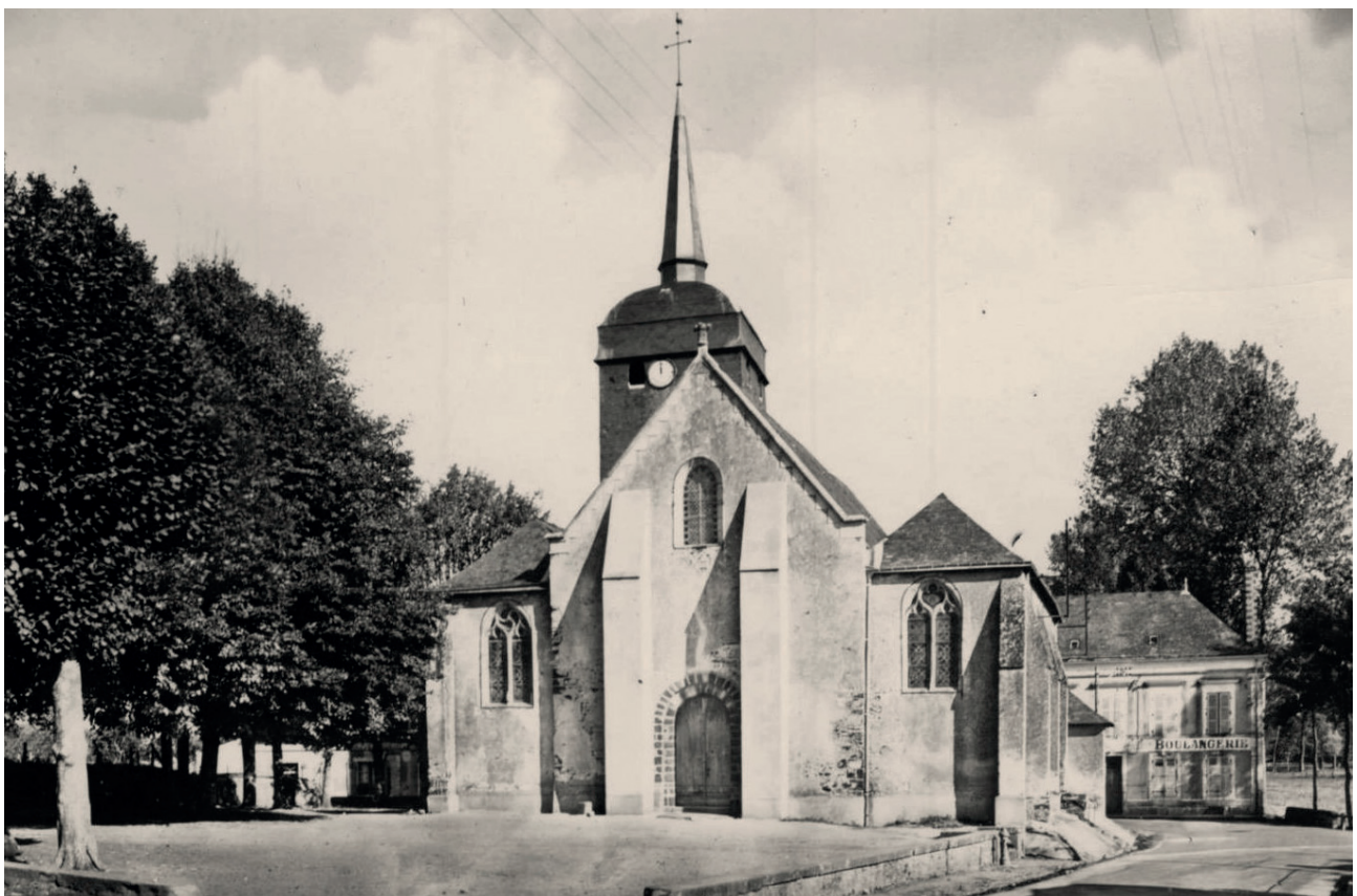
▲ La façade occidentale au milieu du XX e siècle, avec deux contreforts ©Delcampe
