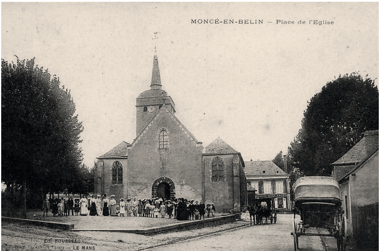
▲ La façade occidentale au début du XX e siècle, sans contrefort ©Delcampe
