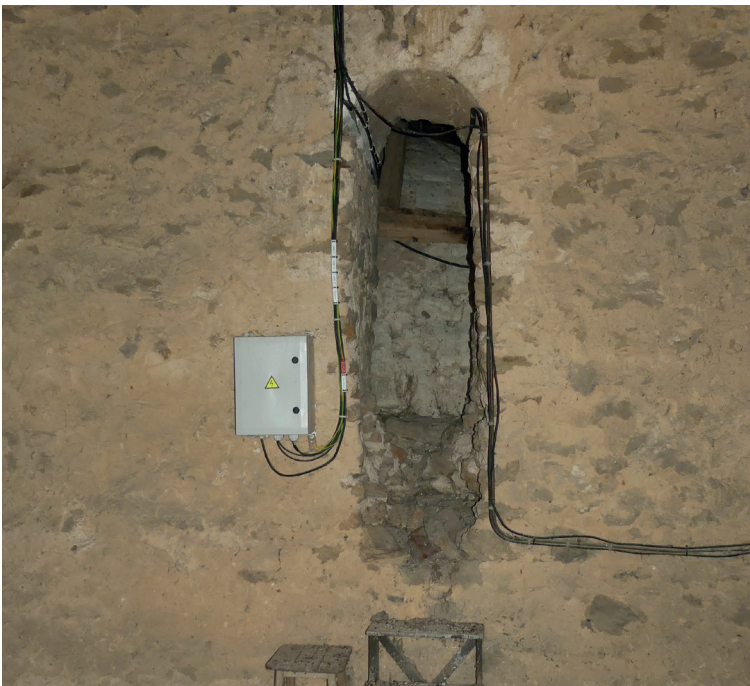
▲ Passage vers les combles du choeur
